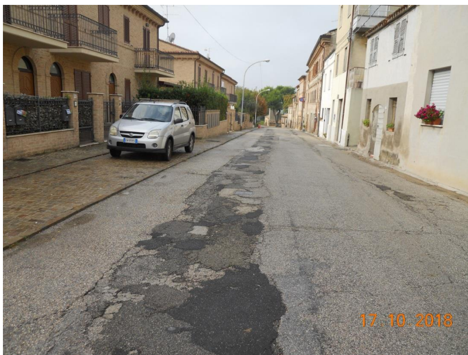
Foto2 - Avvallamenti del piano viario con fessurazioni longitudinali e trasversali della pavimentazione stradale connessi anche alla realizzazione di sottoservizi ed usura dello strato superficiale.
