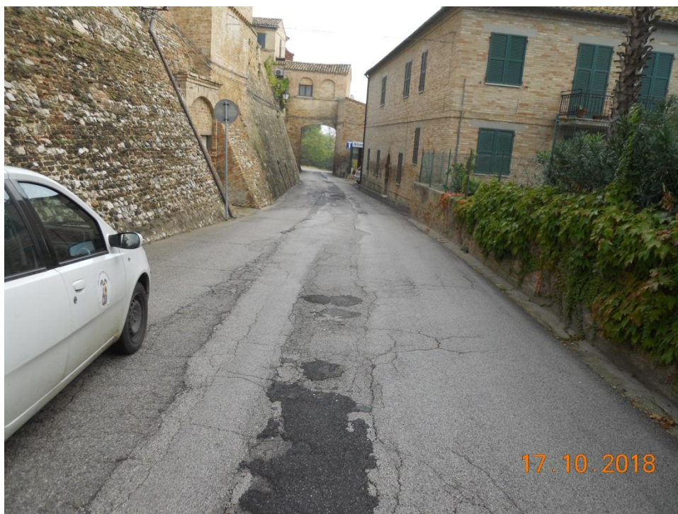
Foto1 - Avvallamenti del piano viario con fessurazioni longitudinali e trasversali della pavimentazione stradale connessi anche alla realizzazione di sottoservizi ed usura dello strato superficiale.
