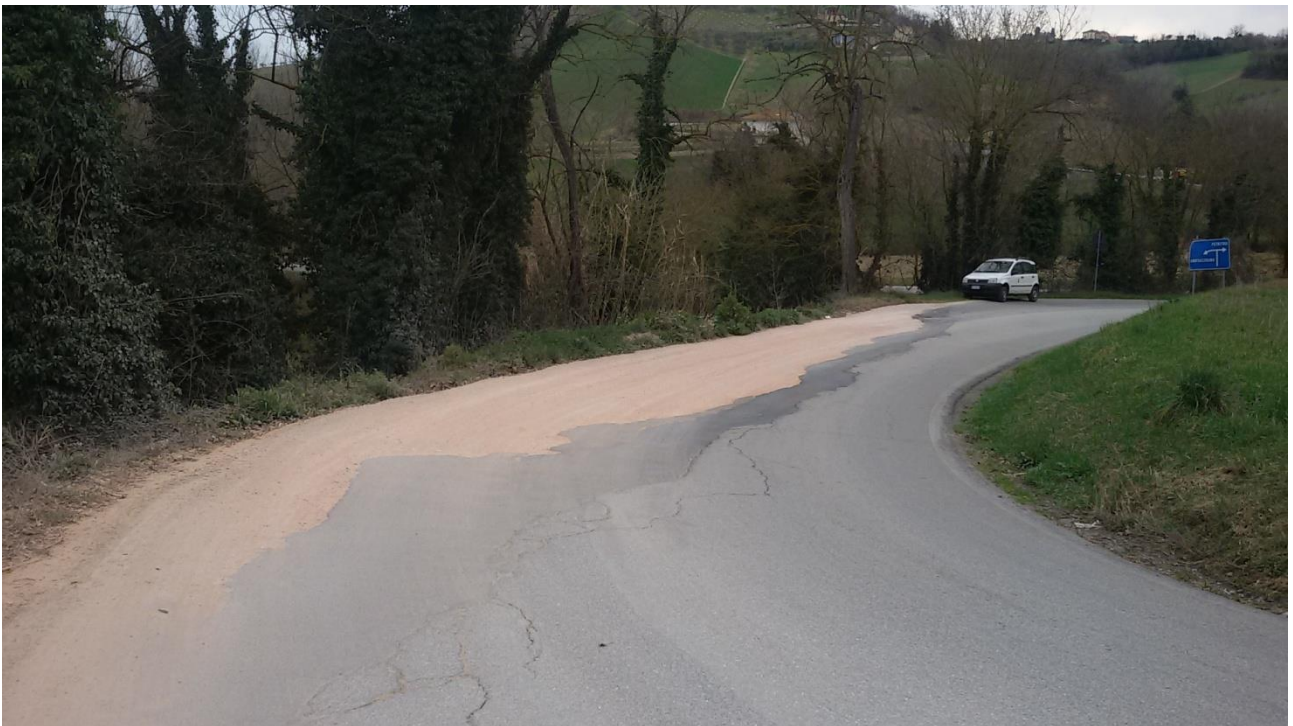
Foto2 - Km 20+700. Cedimento della scarpata stradale di valle con avvallamento longitudinale del piano viario
