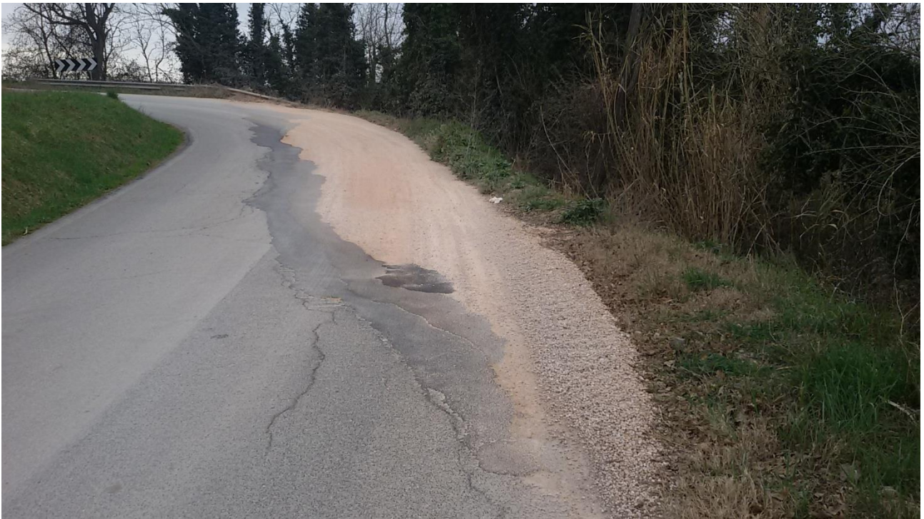
Foto1 – Km 20+700. Cedimento della scarpata stradale di valle con avvallamento longitudinale del piano viario.
