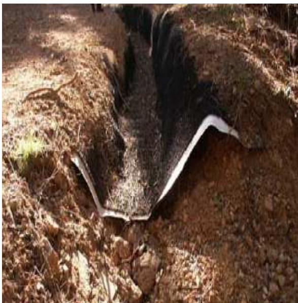
- Fig. 2: Esempio di canaletta flessibile in geocomposito –
