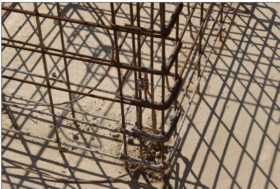
Figura 2 - Foto plinto di fondazione con connessione di terra (opificio "B").
