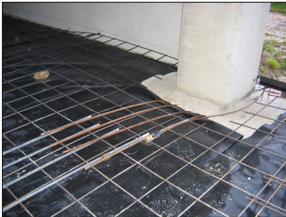
Figura 3 - Foto plinto di fondazione con connessione di terra (opificio "A").
